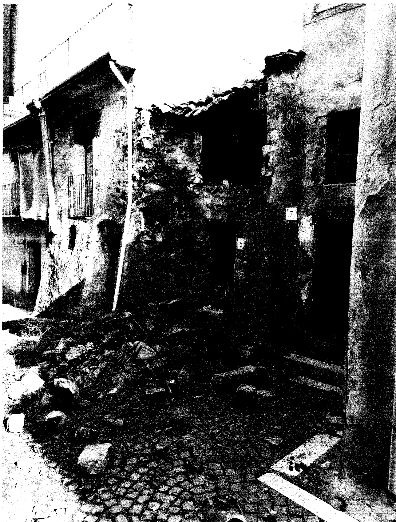
Foto n. 1 – Fabbricato sito in Tusa in Vicolo Marcellino n. 5
